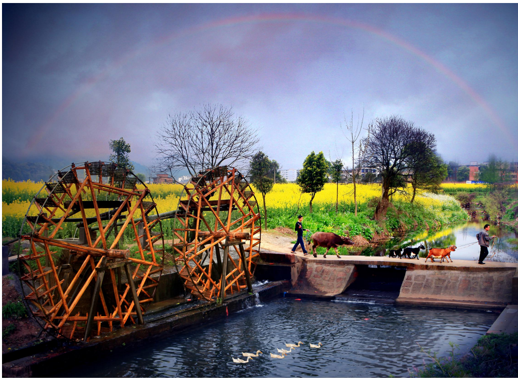
渠系建筑物——农桥
