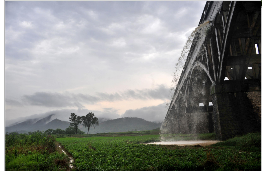
渠系建筑物——渡槽
